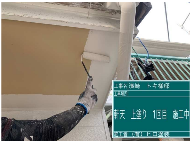
9 軒天 上塗り 1回目 施工中
