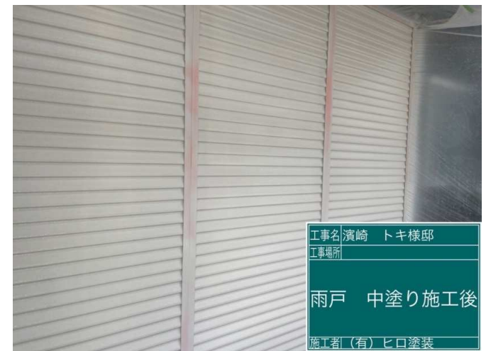
28 雨戸 中塗り 施工完了
