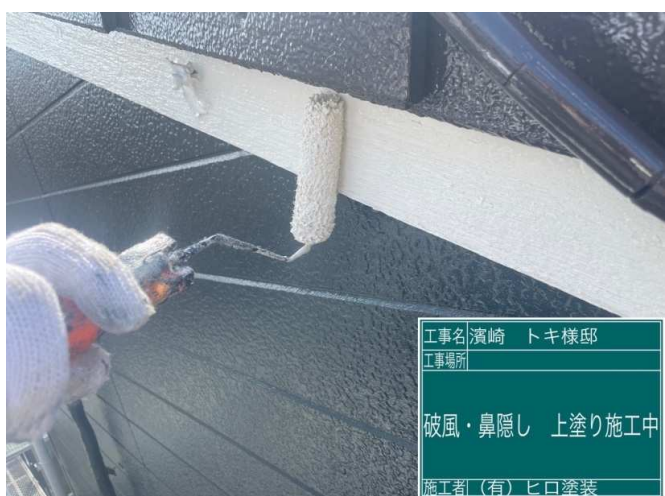
23 破風板 上塗り 施工中
