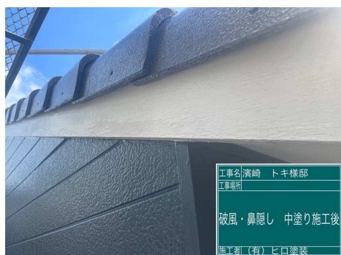
22 破風板 中塗り 施工完了
