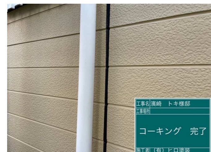
6 コーキング充填 施工完了
