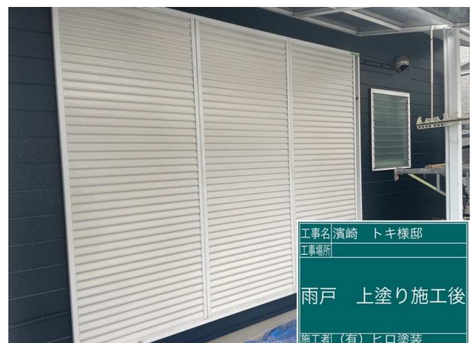
30 雨戸 上塗り 施工完了
