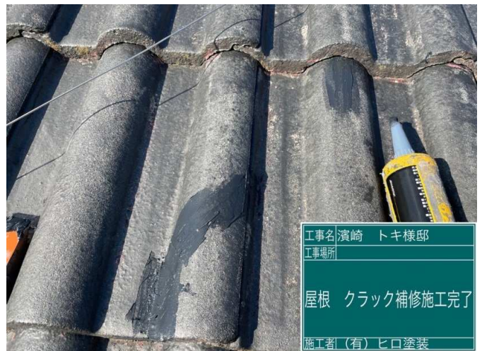
8 屋根 クラック補修 施工完了
