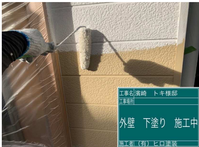
13 外壁 下塗り 施工中
