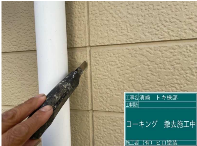
3 コーキング撤去 施工中
