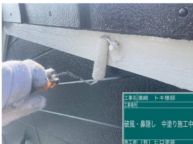
21 破風板 中塗り 施工中
