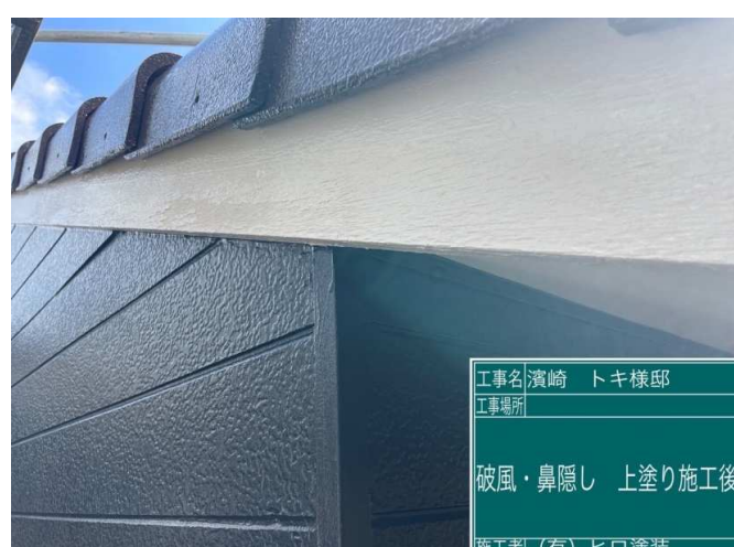
24 破風板 上塗り 施工完了
