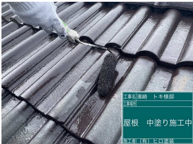
33 屋根 中塗り 施工中
