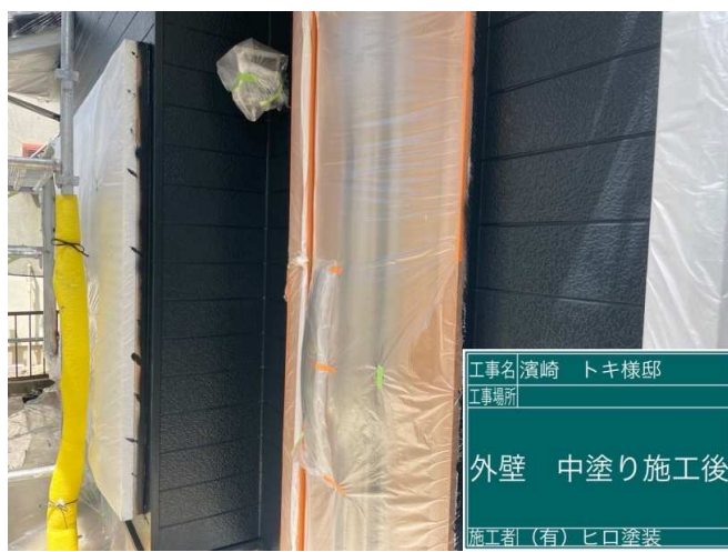
16 外壁 中塗り 施工完了
