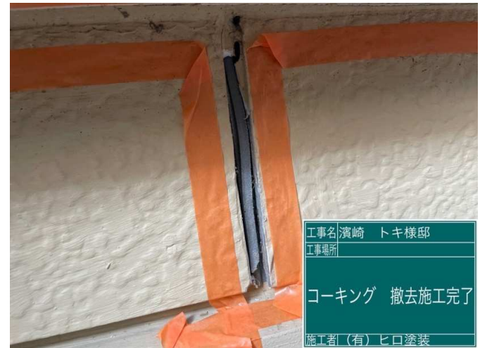
4 コーキング撤去 施工完了
