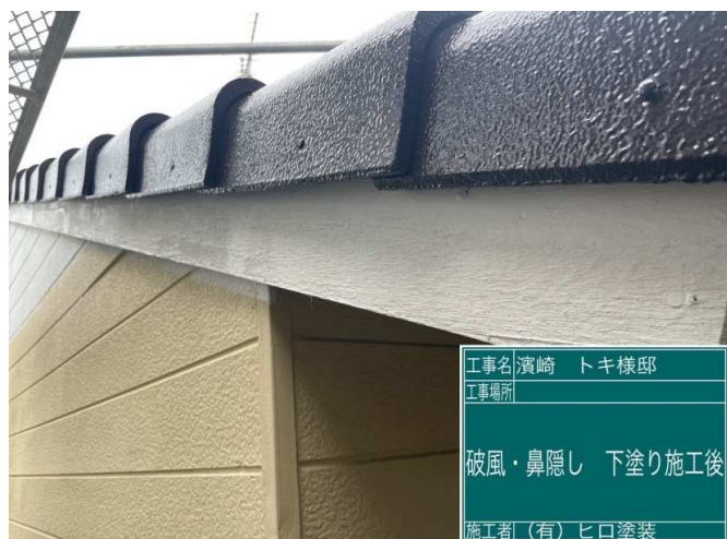
20 破風板 下塗り 施工完了
