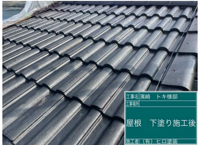
32 屋根 下塗り 施工完了
