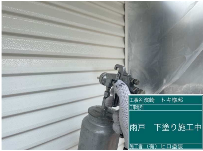
25 雨戸 下塗り 施工中
