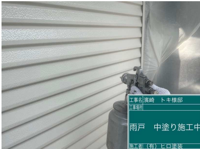
27 雨戸 中塗り 施工中
