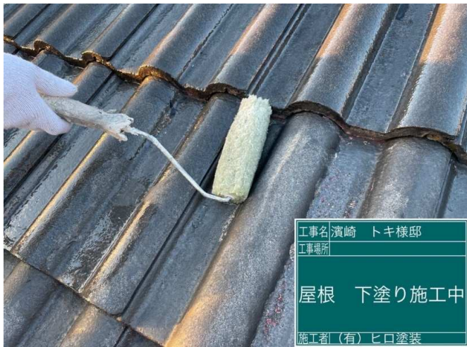
31 屋根 下塗り 施工中
