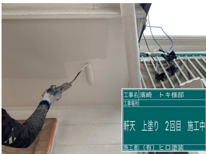
11 軒天 上塗り 2回目 施工中
