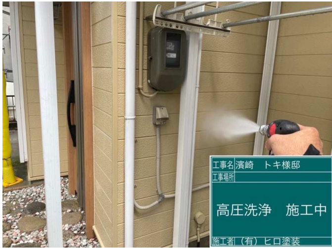
1 高圧洗浄 施工中
