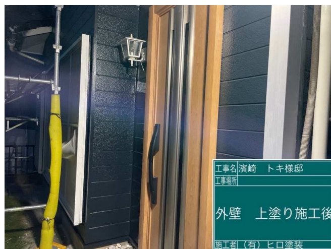
18 外壁 上塗り 施工完了
