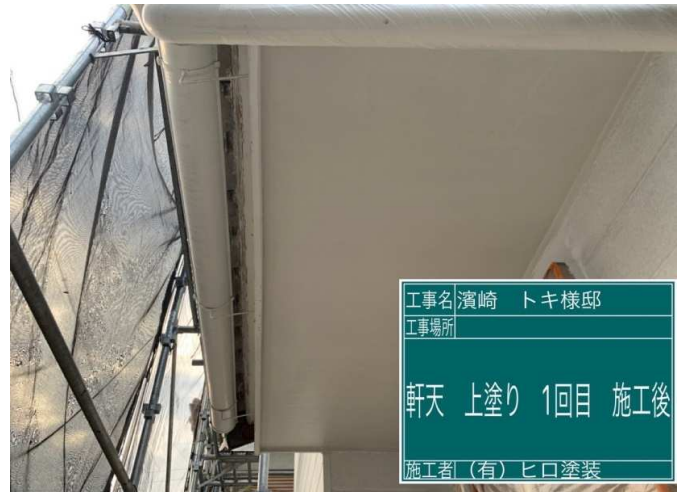
10 軒天 上塗り 1回目 施工完了
