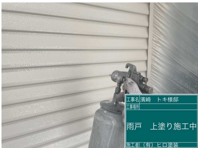
29 雨戸 上塗り 施工中
