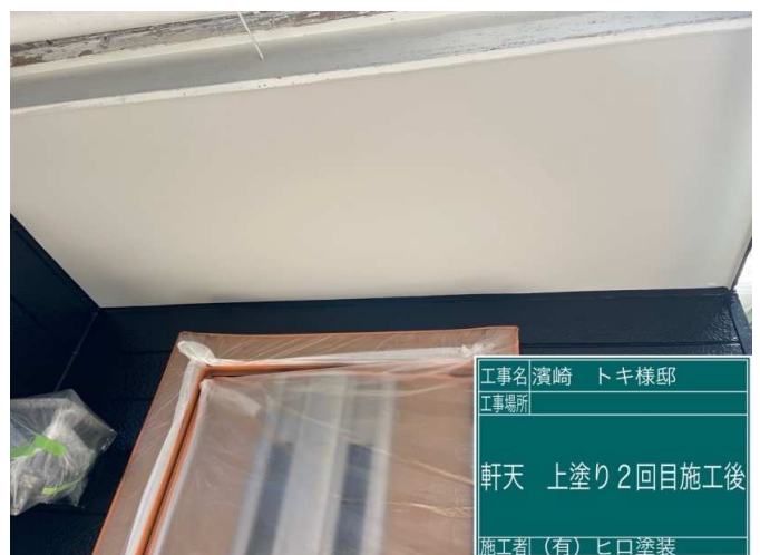
12 軒天 上塗り 2回目 施工完了
