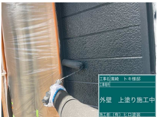
17 外壁 上塗り 施工中
