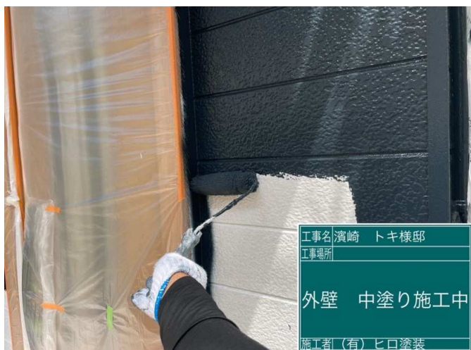
15 外壁 中塗り 施工中
