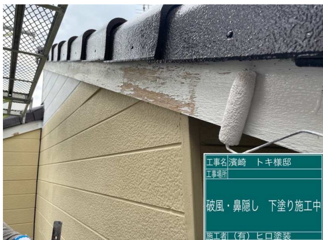
19 破風板 下塗り 施工中
