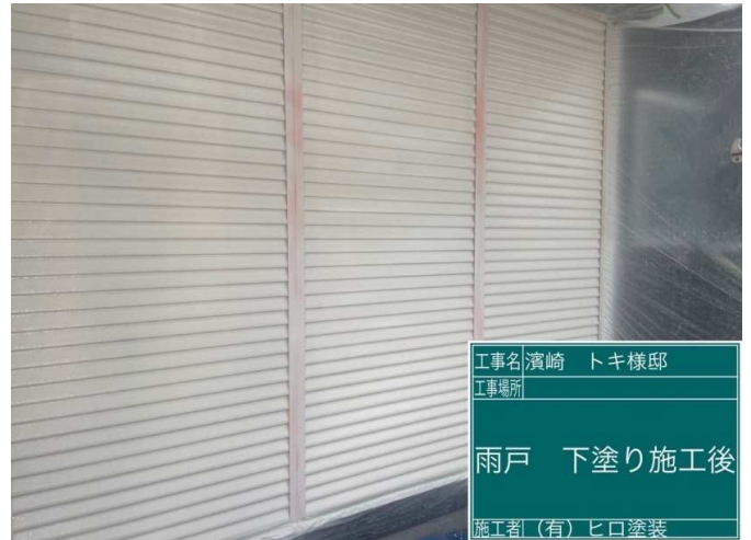
26 雨戸 下塗り 施工完了
