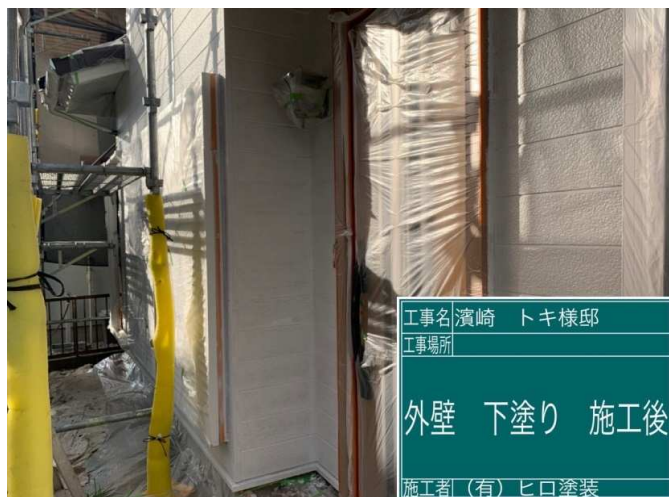
14 外壁 下塗り 施工完了
