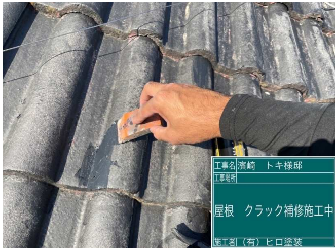
7 屋根 クラック補修 施工中
