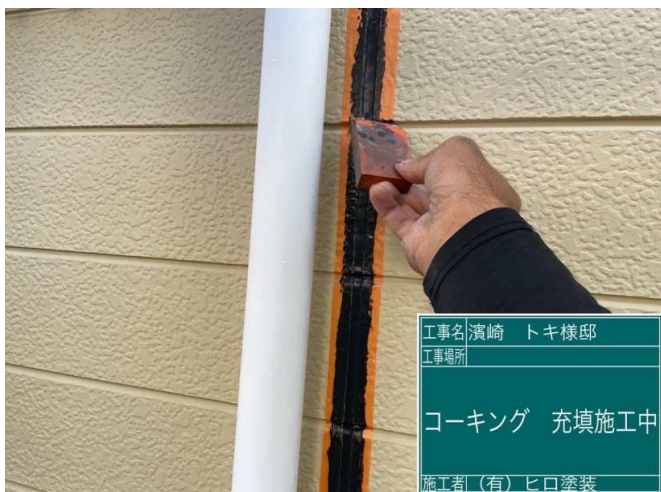
5 コーキング充填 施工中
